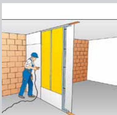
rys. 6 Pokrycie drugiej strony ściany
