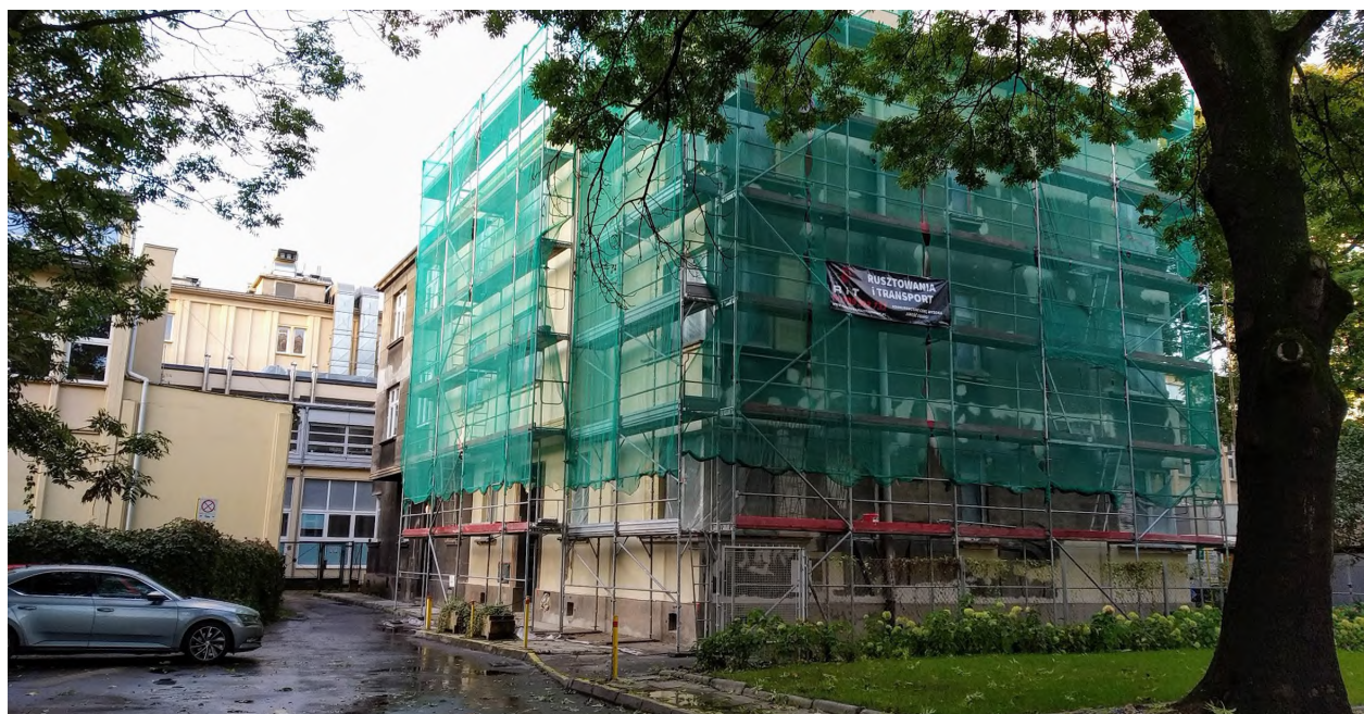
Rusztowanie ramowe podczas prowadzonego remontu elewacji kamienicy
