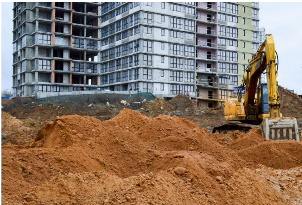
W rejonach wykopów obowiązują odpowiednie odległości od ich krawędzi ze względu na bezpieczeństwo sprzętu, jak również pracowników i operatora
