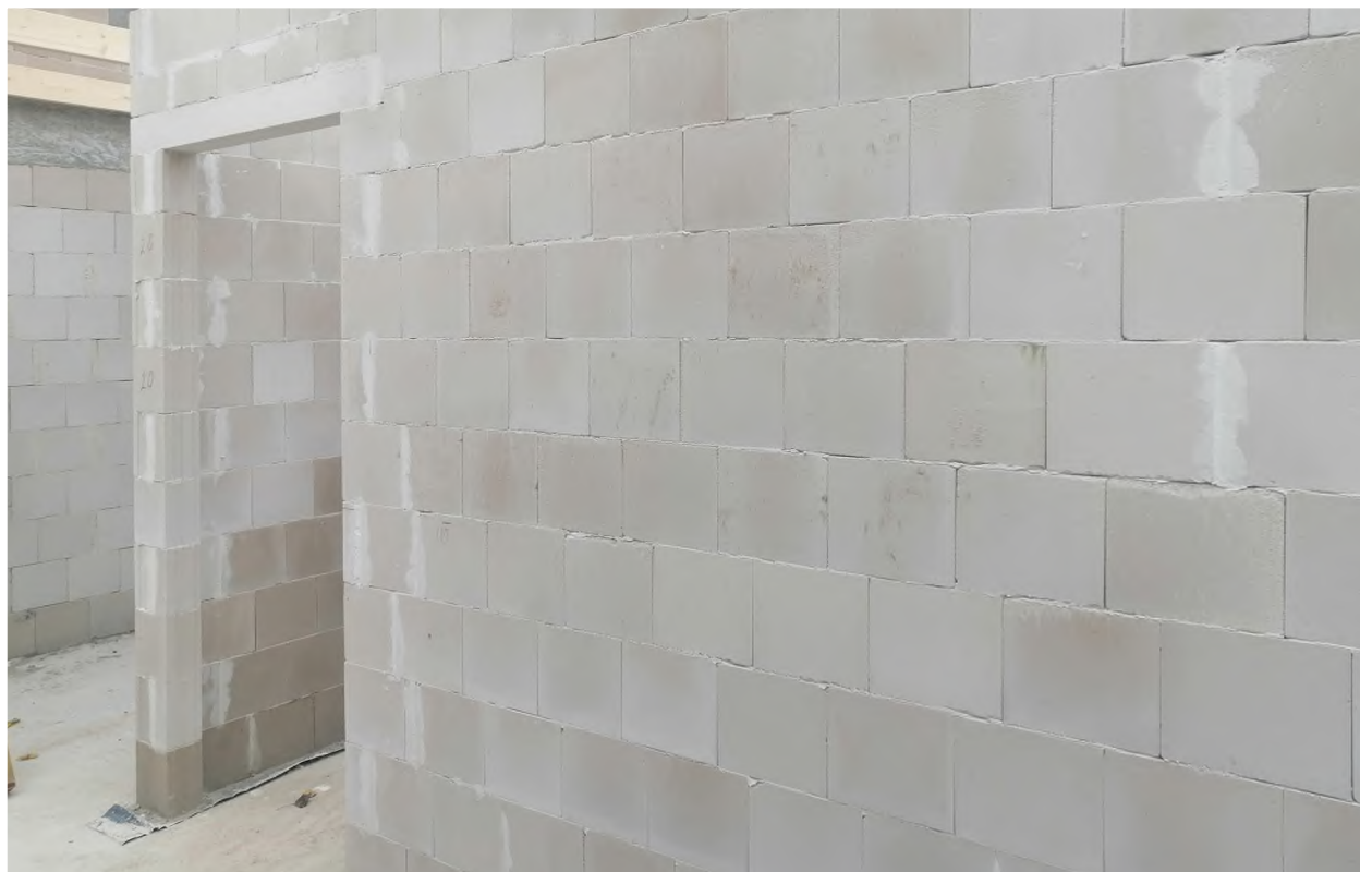
Przemurowanie bloczków w ścianie zależy od wysokości elementów murowych
