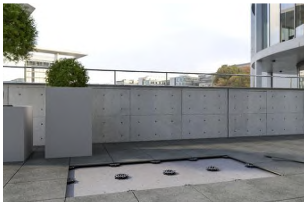
Taras z płyt betonowych ułożonych na podstawkach dystansowych
