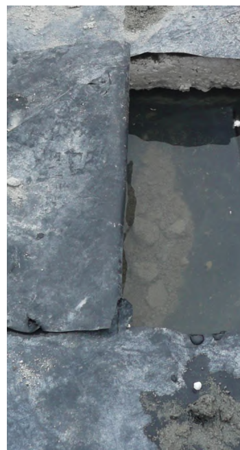
Fot. 1 Skutki stosowania folii 0,2 mm jako hydroizolacji połąci
