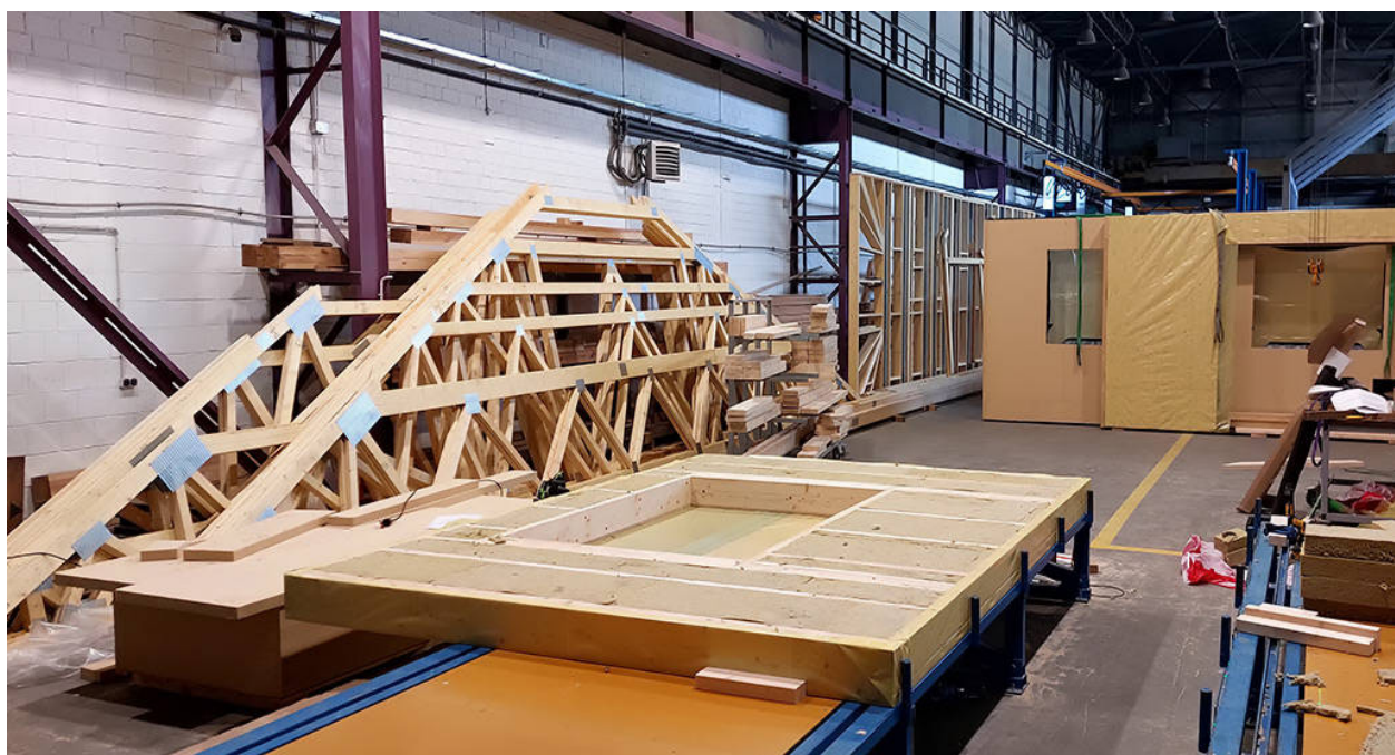
Wszystkie elementy w technologii prefabrykowanego szkieletu drewnianego są wykonywane zgodnie z projektem budowlanym
