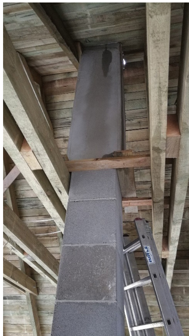
Fot. 6 Ocieplenie komina poniżej wyprowadzenia nad dach, w nieogrzewanej części poddasza
