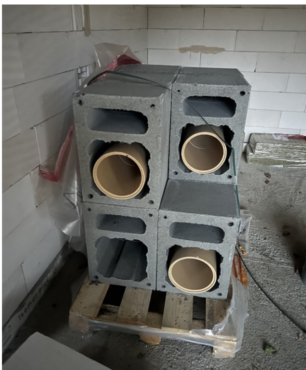
Fot. 3 Kształtki do budowy komina dymowego do kominka dostarczone na budowę
