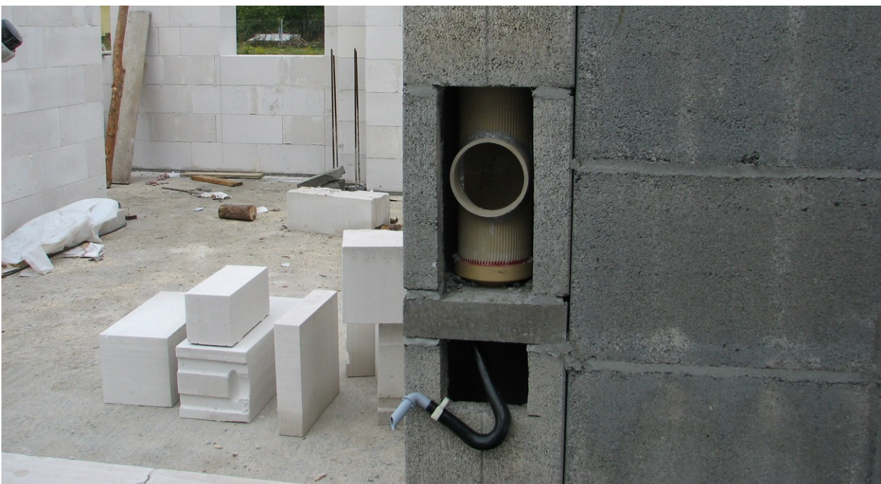
Fot. 2 Dolna część kominu spalinowego – odprowadzenie kondensatu i trójnik do podłączenia urządzenia grzewczego
