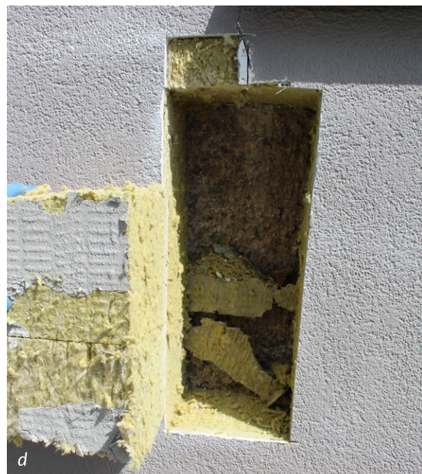
Fot. 4 a-d – zarysowania powstałe na skutek niestabilnego podłoża (opis w tekście)
