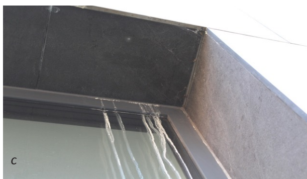
Fot. 7a-c – wady spowodowane przeciekami są wyjątkowo trudne w usunięciu i wymagają zawsze szczegółowej analizy cieplno-wilgotnościowej
