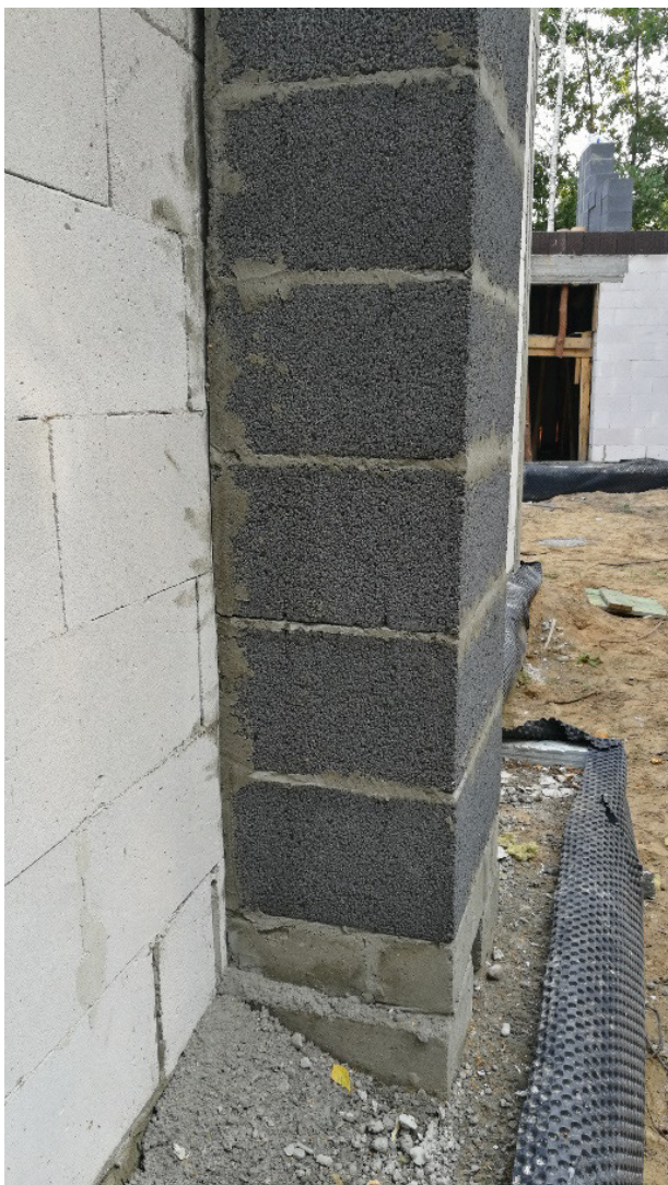
Fot. 5 Cokół komina wykonuje się z pustaków wypełnionych betonem lub z bloczków pełnych
