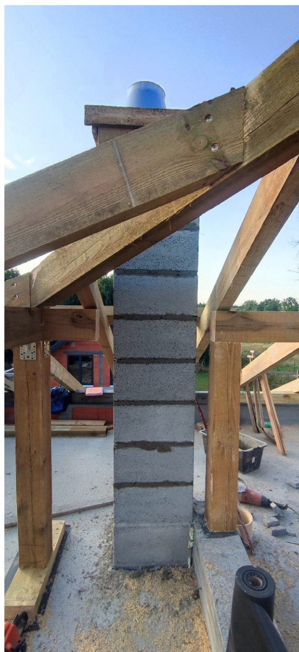
Fot. 1 Kominy z pustaków systemowych zastąpiły te murowane z cegieł
