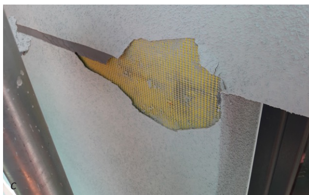
Fot. 3 a – rysa w narożniku pomimo obecności siatki diagonalnej b – przykład rysy, której geometria zdaje się sugerować, że jej powodem może być brak siatek diagonalnych (opis w tekście) c – znaczącym (jeżeli nie głównym) powodem powstania rysy były błędy w wykonaniu warstwy zbrojącej
