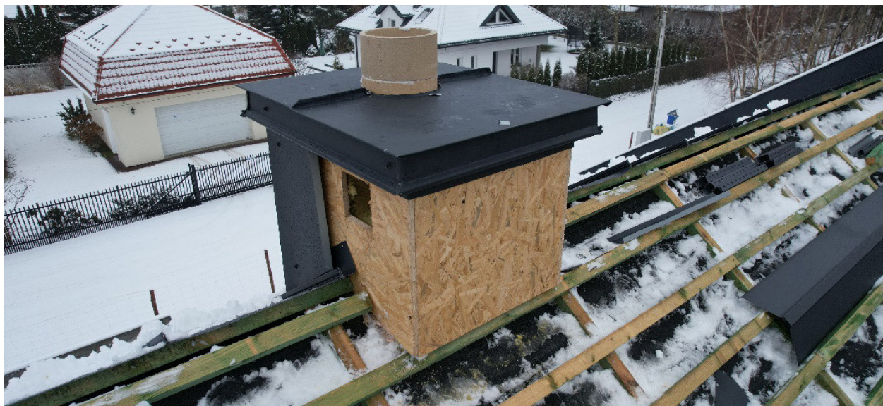
Fot. 11 Do obudowy komina ponad dachem można wykorzystać blachę
